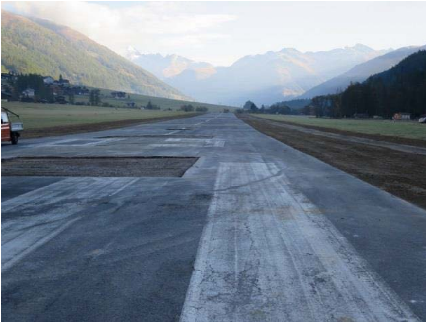
vorbereitete Belagsflicke für den Belagseinbau
